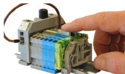
6. Предохранитель в большом блоке клеммной рейки. 10 А 5x20 мм
