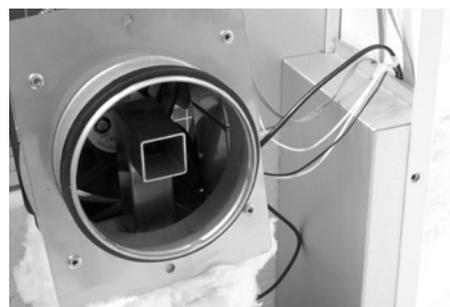
Одновременно можно очистить четырёхугольный или круглый дымоход, расположенный в столе за туалетом. Удалите пылесосом пыль, оставшуюся после очистки щёткой вентилятора щёткой.
